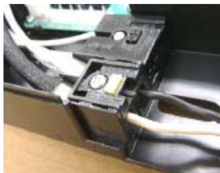
①速結端子直結接続
